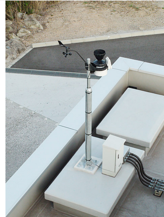
制御棟屋上の気象センサ
